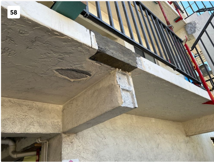
Slab edge concrete repair.
