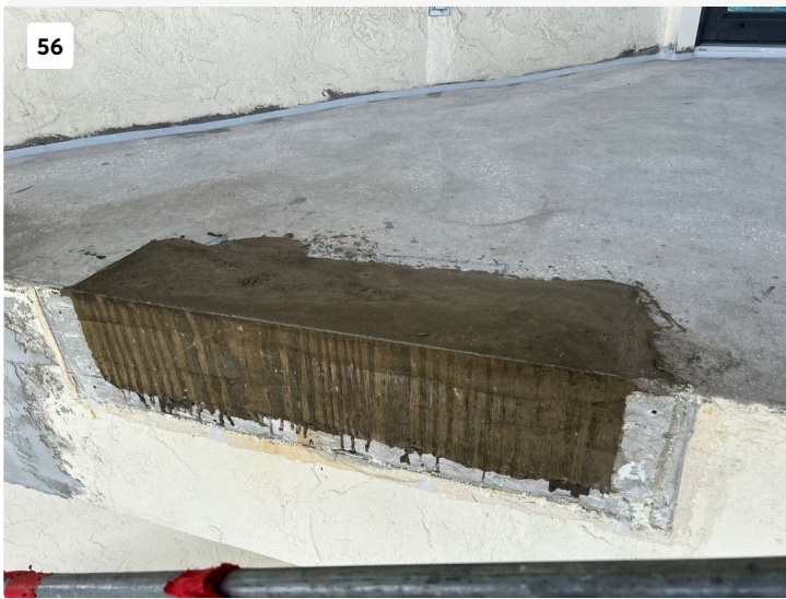
Slab edge concrete repair.
