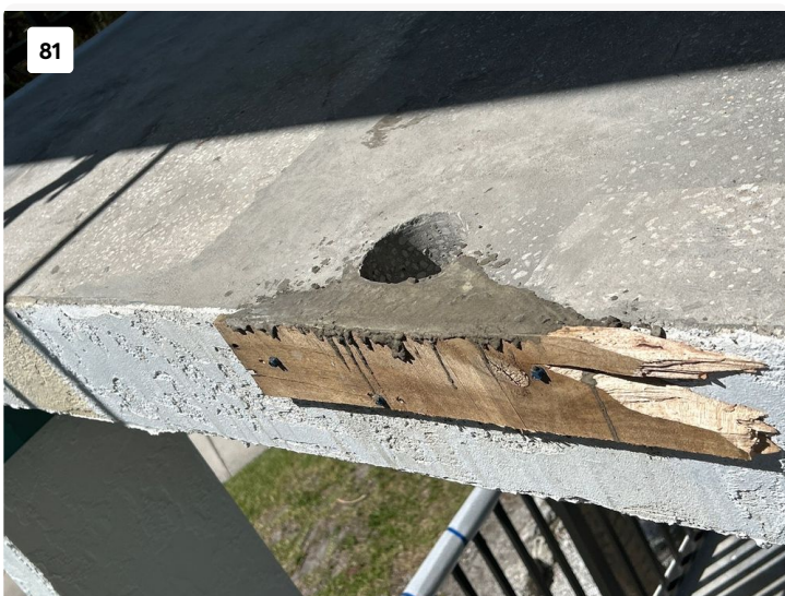
Slab edge repair.
